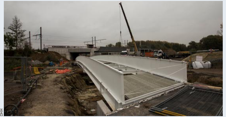
■ De 66 ton zware brug moet nog worden afgewerkt.
