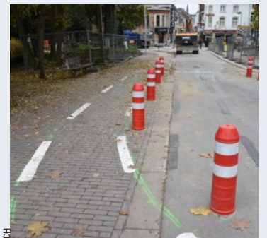
■ Het kruispunt kreeg een nieuw fietspad.
